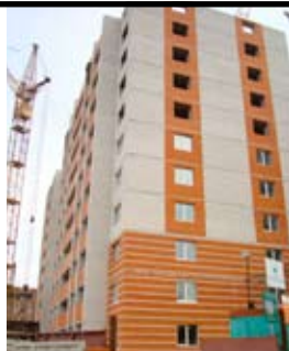
Строительство семнадцатизэтажного жилого дома на ул. Рижская, 6а
